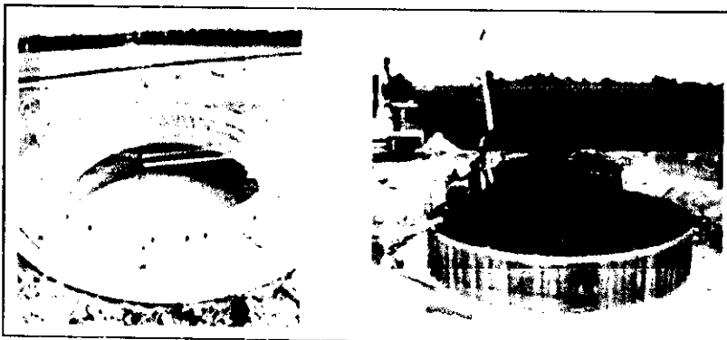
Figure I.10: Les fondations de grandes éoliennes [10].
