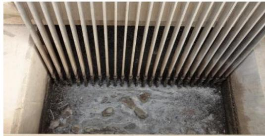
**Fig.11: Dégrilleur (Photo originale, 2017).**
