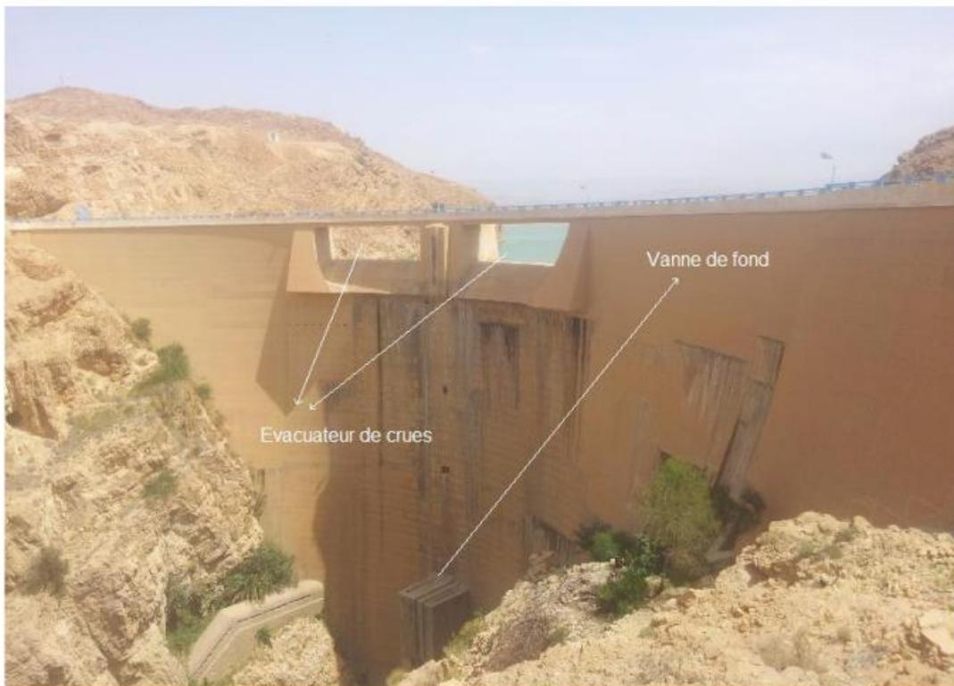
**Figure IV.14** : Vanne de fond du barrage de Foum El Gherza (**Remini, 2016**)
