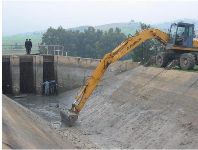
**Figure. II.10.** Curage d'un canal par les moyens mécaniques.
