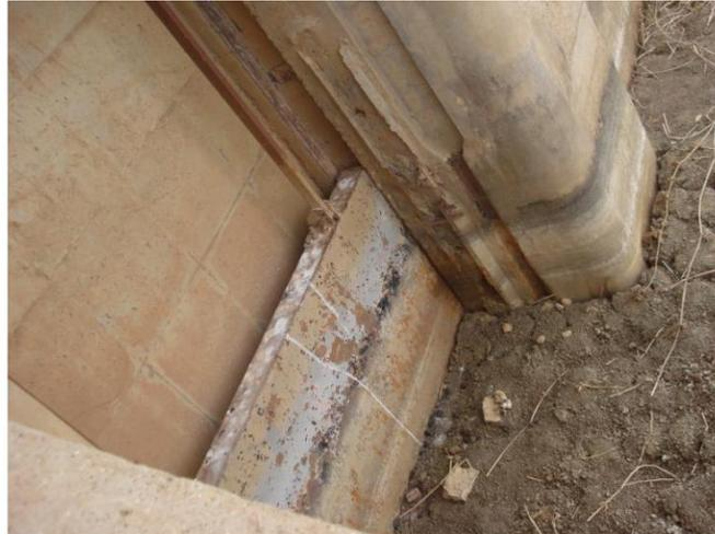
**Figure. II.9.** Blocage des vannes de fond.
