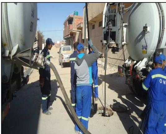
*Photo V.1 Enlèvement des dépôts mécaniques*
