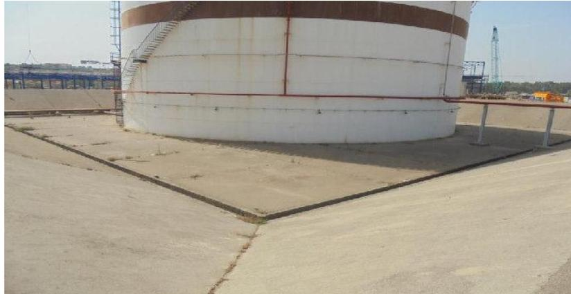
**Figure (III.21): la cuvette de rétention [2].**
