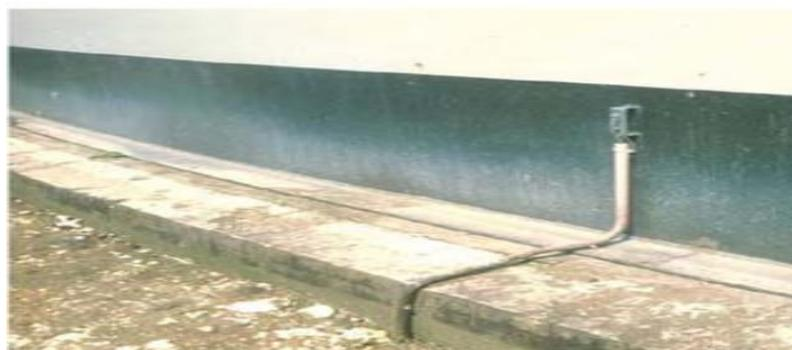
*Figure (III.20): Mise à la terre d'un bac [4].*
