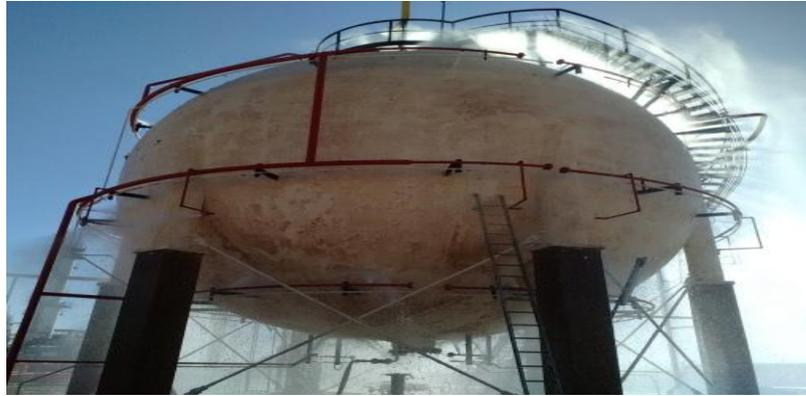
*Figure (III.32): Réservoir sphérique à gaz liquéfiés [6].*
