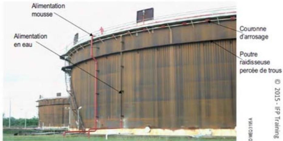
*Figure (III.28): Dispositif d'arrosage de la robe d'un bac [4].*
