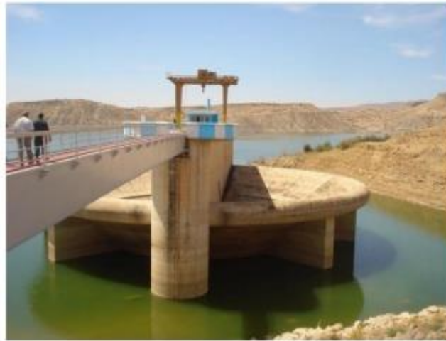
Figure II.11: Couleur verdâtre de l'eau du barrage de SMBA.
