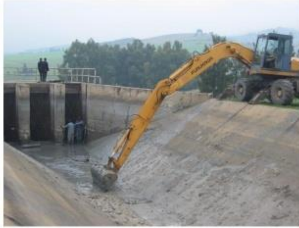
Figure II.10: Curage d'un canal par les moyens mécaniques(OPIM, 2008).
