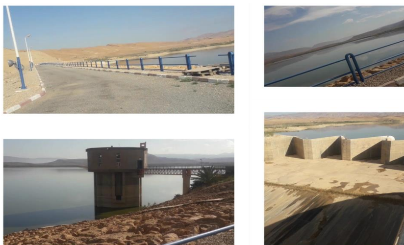
Figure I.1 : barrage de Fontaine des Gazelles (2021).
