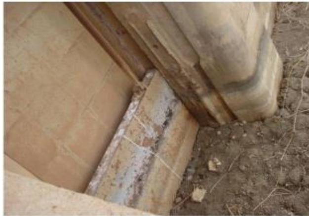
Figure II.9: Blocage des vannes de fond (Remini, 2011).
