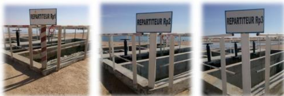
Figure 10 : Répartiteur dans bassins d'aération
