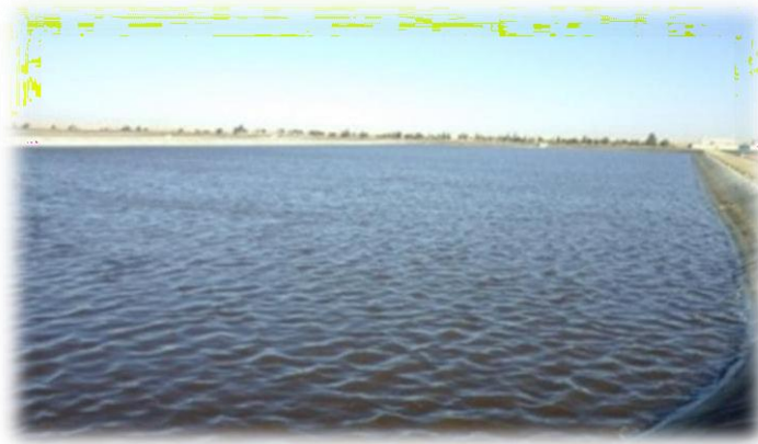
Figure 13 : lagune de finition
