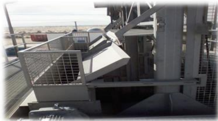
Figure 8 : Dégrilleurs
