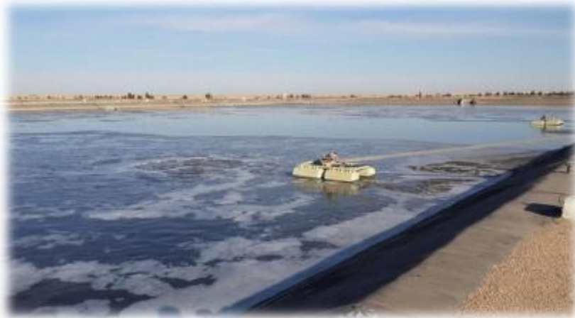
Figure 11 : Lagune aérée step 2.
