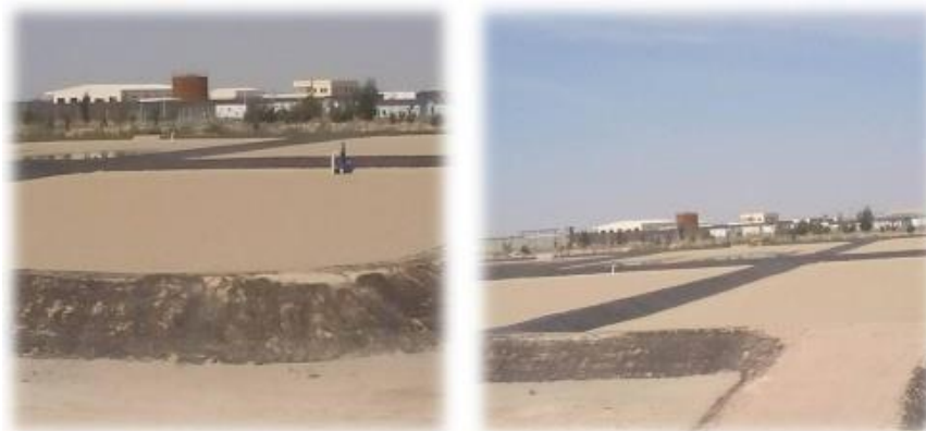
Figure 14 : lits de séchage des boues.
