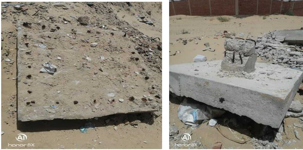
Figure II.3 : Des fondations démolies.
