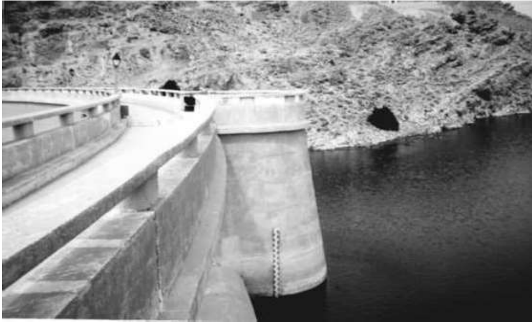
Figure 7: Barrage de Foug-el-Gherza , Biskra, Algérie. Capacité initiale 47.106 m 3
