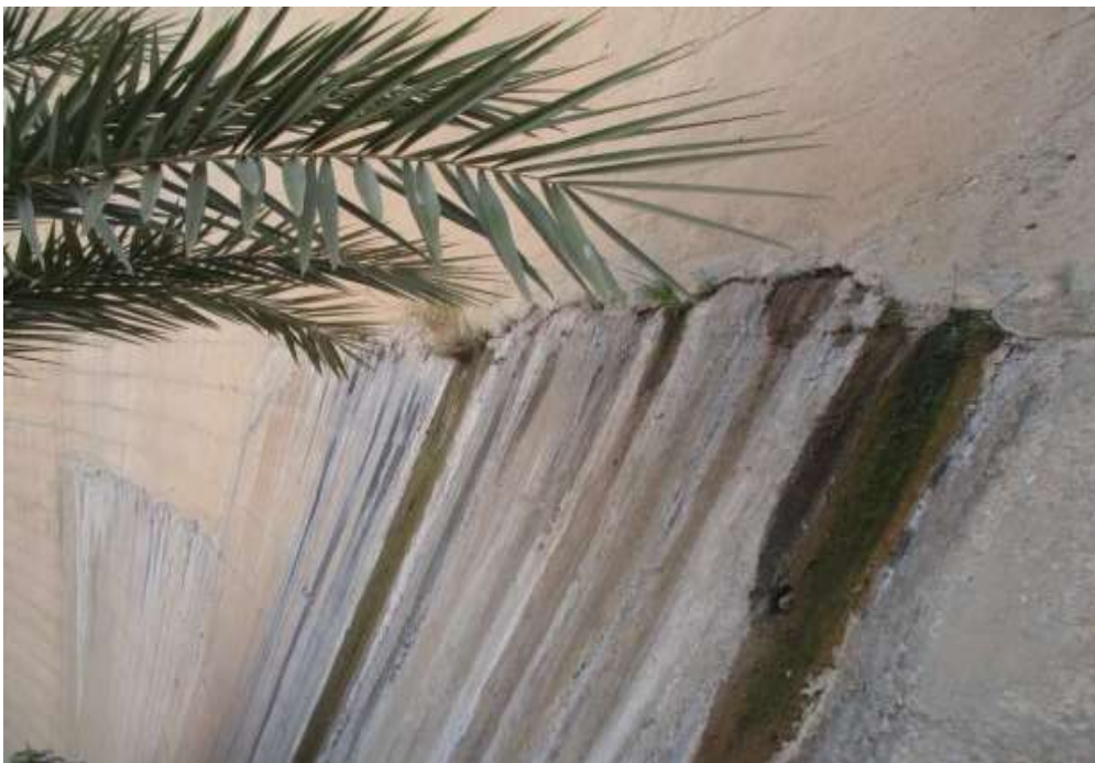
Figure 29 Une fuite d'eau bien visible bien que le lac est au niveau le plus bas
