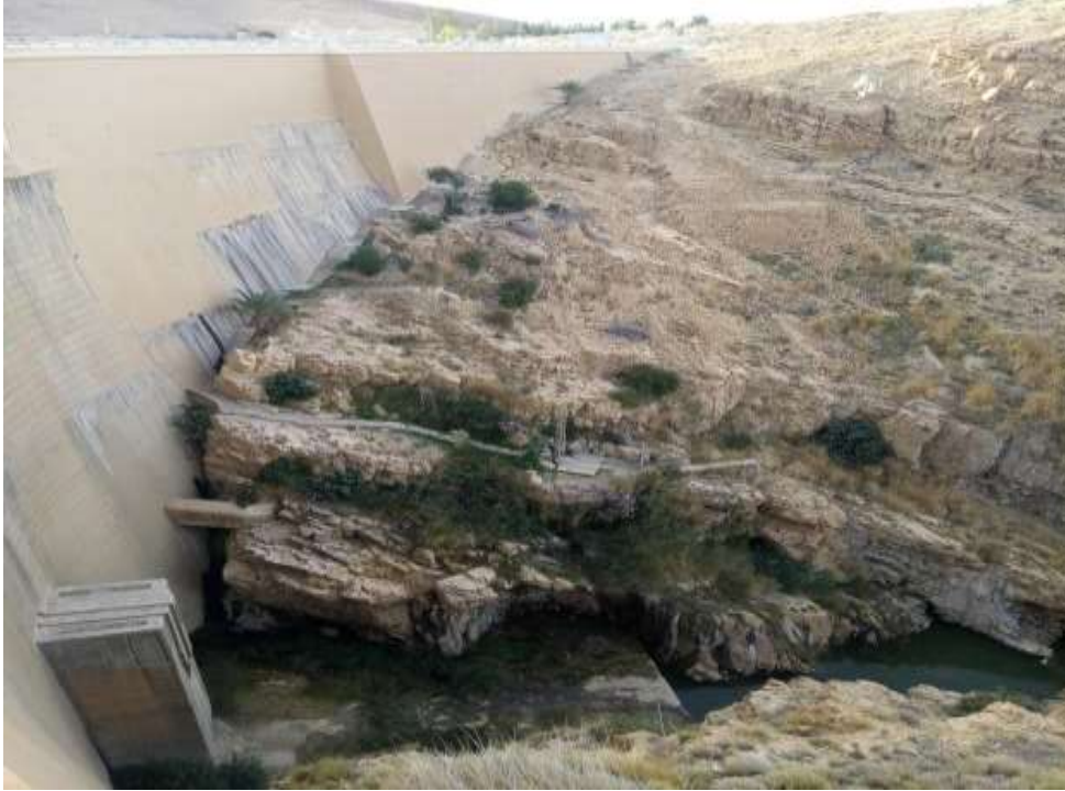
Figure 30: Une vue des infiltrations par la digue de la rive gauche du barrage de Foum El Gherza
