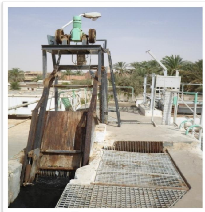
Figure 8: photo du dégrilleur
