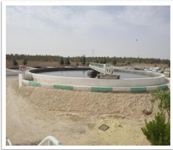
Figure 11: photo du décanteur secondaire
