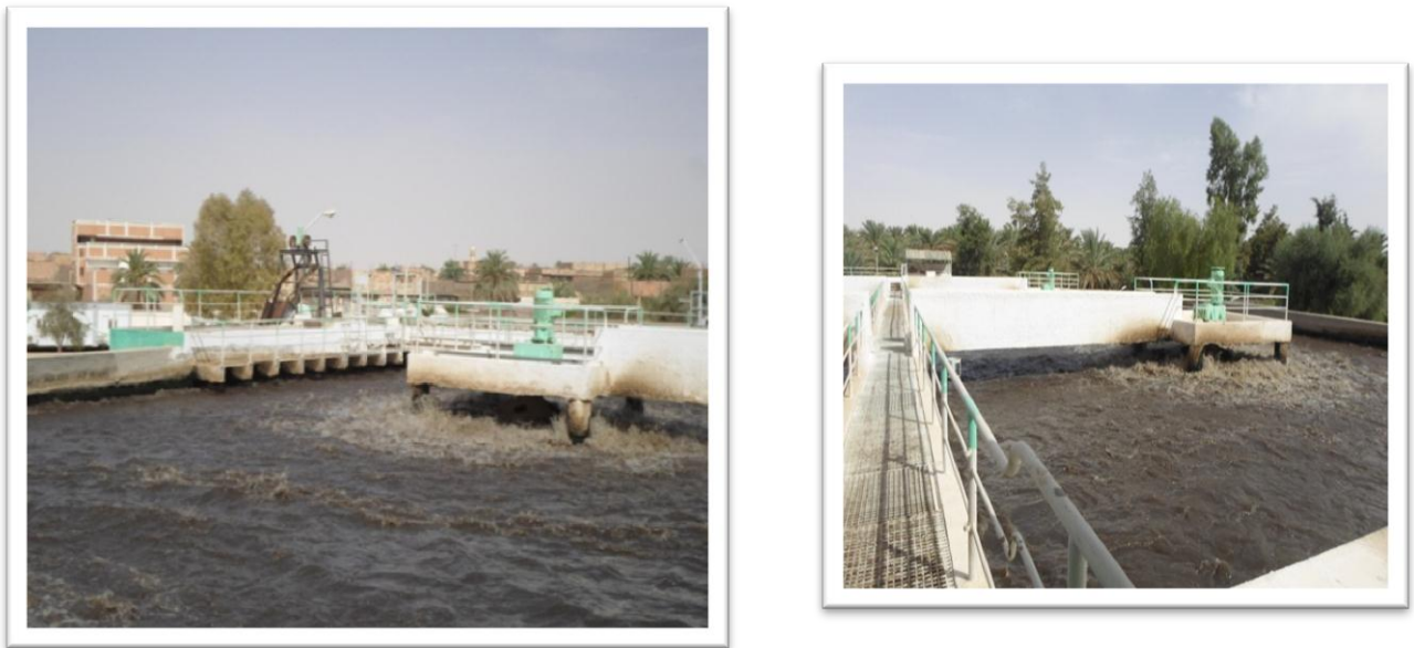
Figure 10: photo du bassin d'aération
