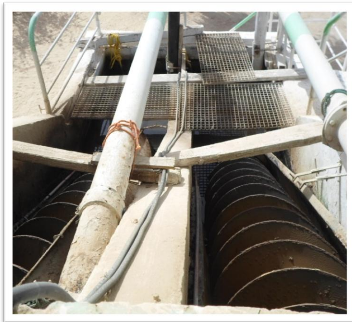
Figure 13: photo vis d'Archimède
