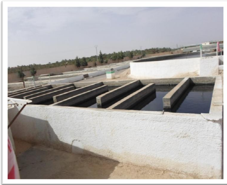
Figure 12: photo du bassin de chloration
