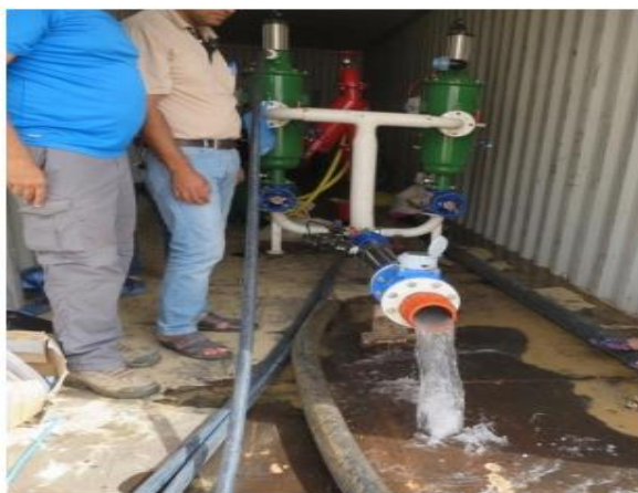
photo 07 : L'appareil utilisé dans la station
