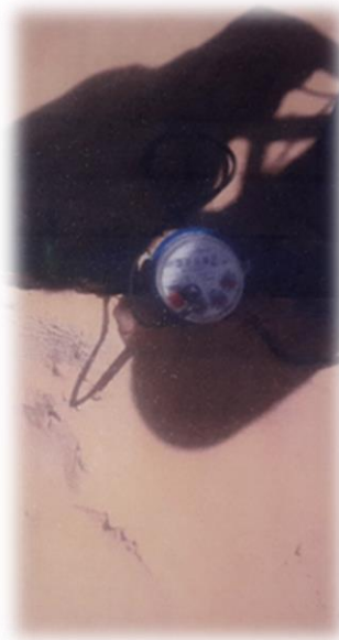
le compteur d'eau
