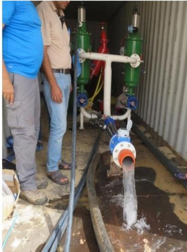
Photo 01 : L'appareil utilisé dans la station
