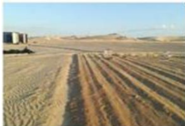
Photo 04 : Préparation du sol
