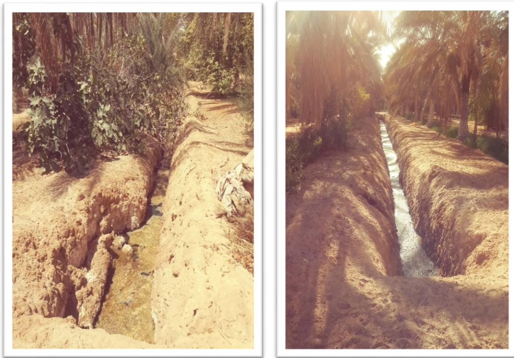
Figure 17 : Drains à ciel ouvert (photos originales)
