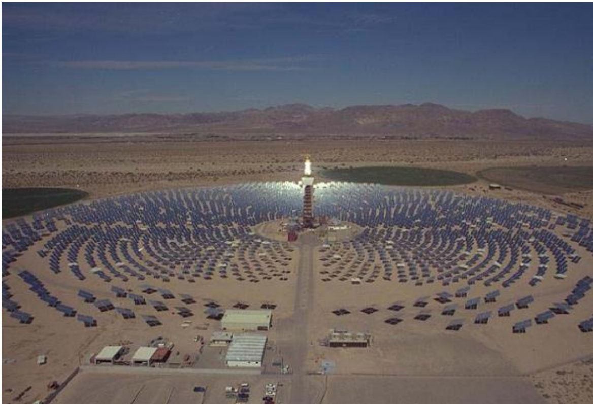
Fig II.13: système de centrale à tour
