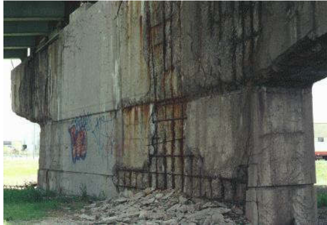
Figure III .4: Aggression du béton par activité des chlorures. [26]
