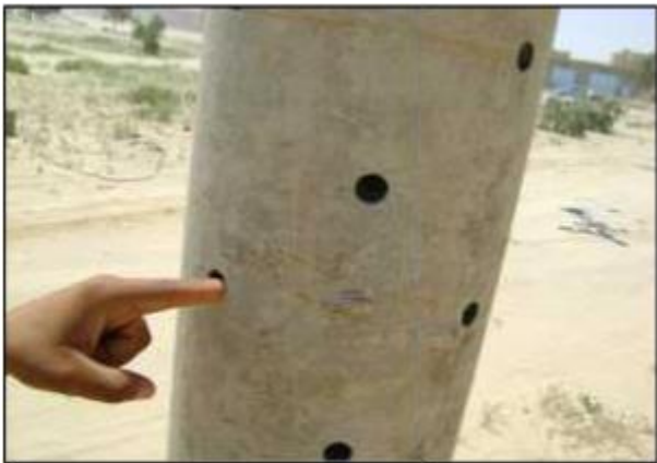
Photo. N°: (01) Conduite d'amiante ciment utilisée dans le réseau drainage horizontale.
