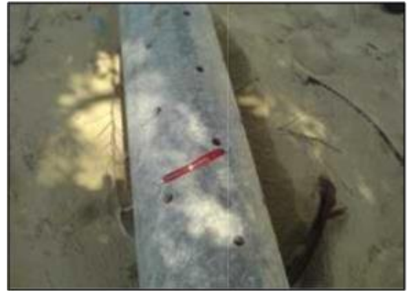
Photo. N°: (01) Conduite d'amiante ciment utilisée dans le réseau drainage horizontale.
