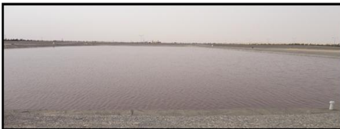
Figure18 : Lagune de finition
