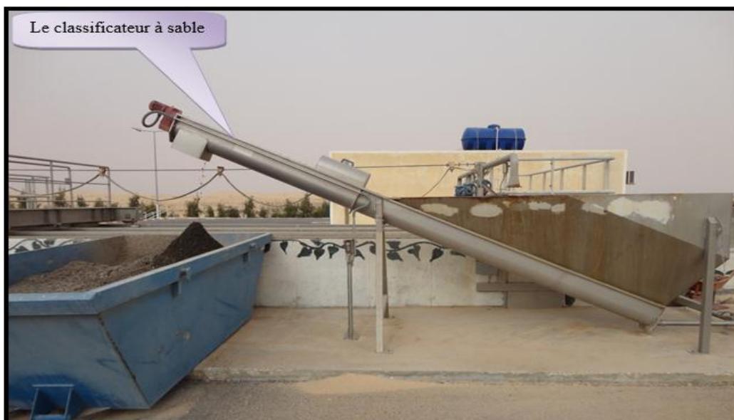
Figure15: Clarificateur à sable
