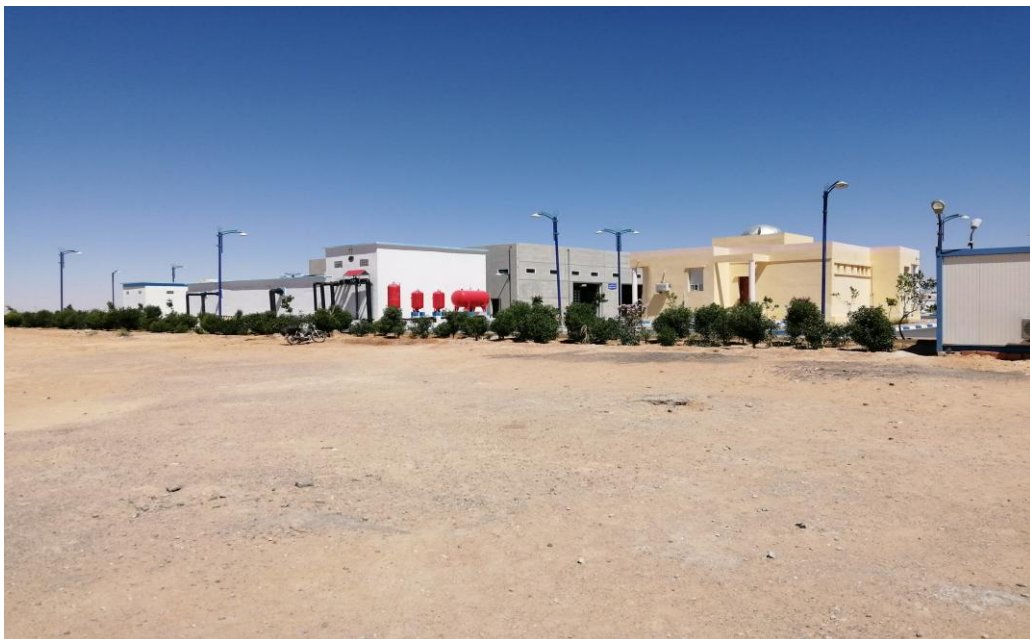
Figure IV-1 : photos de la station de déminéralisation d'El Meghaier.
