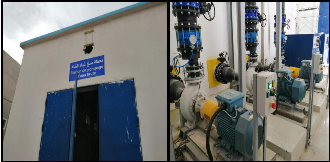
Figure IV-4 : Pompe d'alimentation des filtres.
