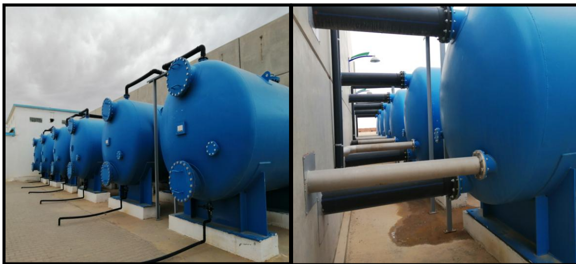
Figure IV-5 : les filtres à sable
