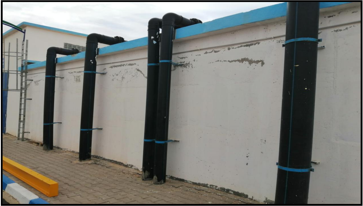
Figure IV-3 : Bassin de stockage des eaux brutes
