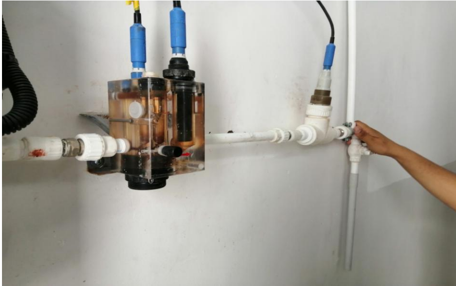
Figure IV-8 : pompe doseuse de chlore
