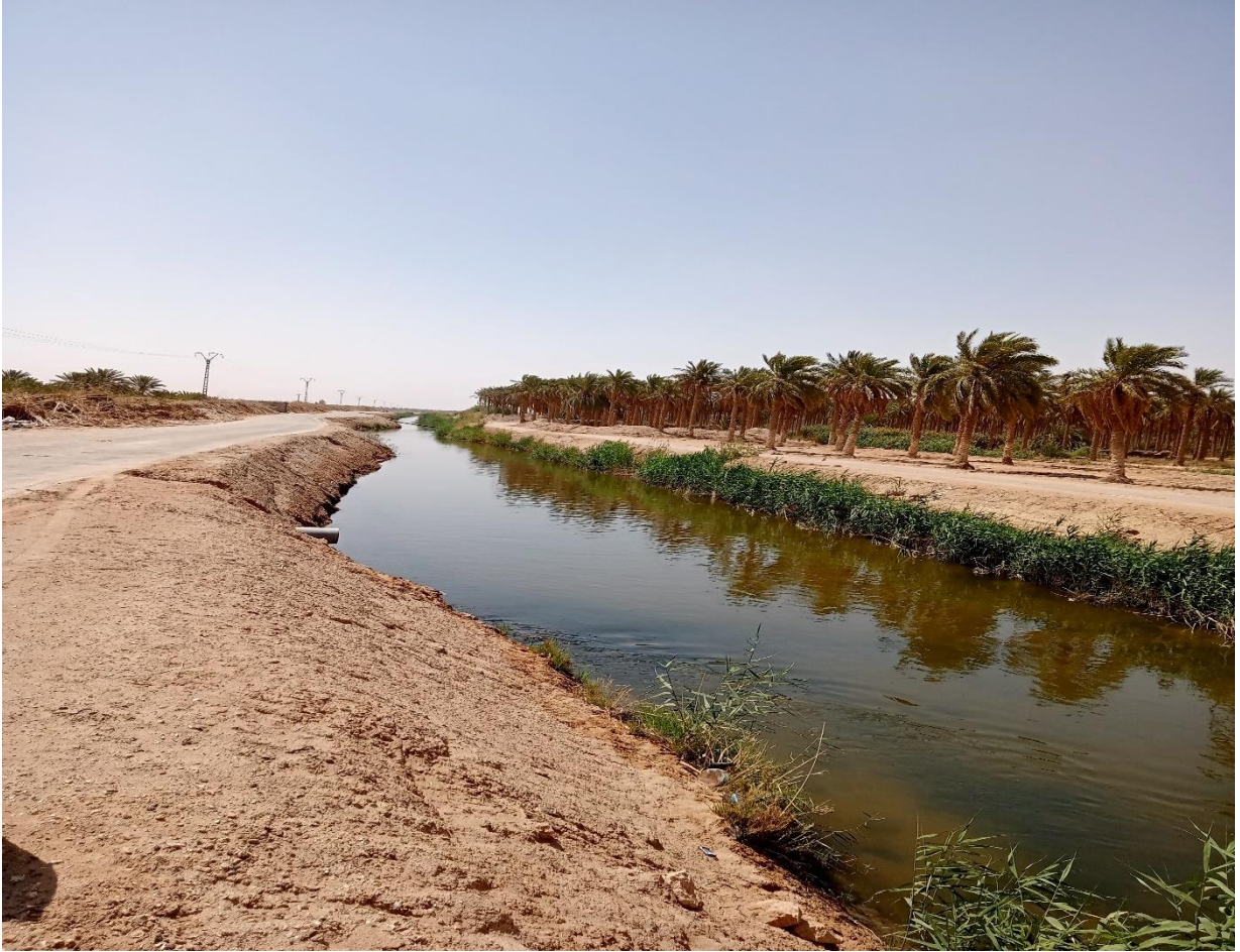
Photo 2. Destruction des berges en sable à cause des turbulents à Boufeggoussa (2022)
