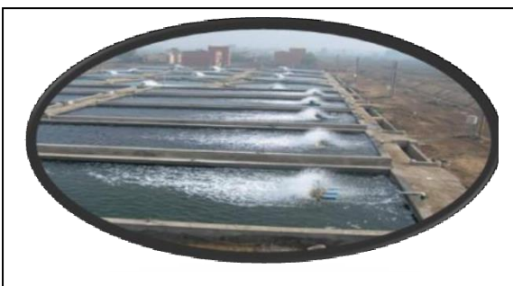
FIGURE 03: BASSIN EN BETON
