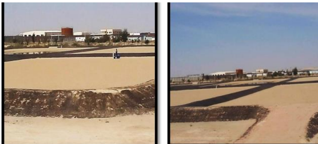
Figure 18: Lit de séchage des boues.
