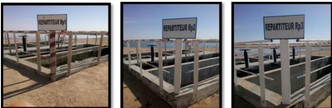
Figure 14: Répartiteur vers les bassins d'aération.
